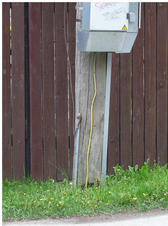
правильная организация заземления: PEN-проводник заземлён как в месте ответвления, так и в узле учёта
