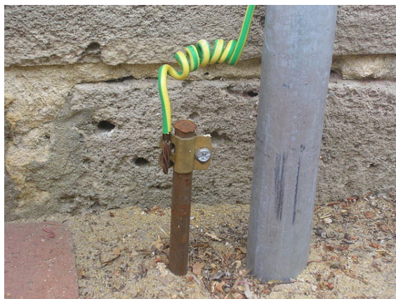
Заземлитель (металлический стержень) с присоединённым заземляющим проводником
